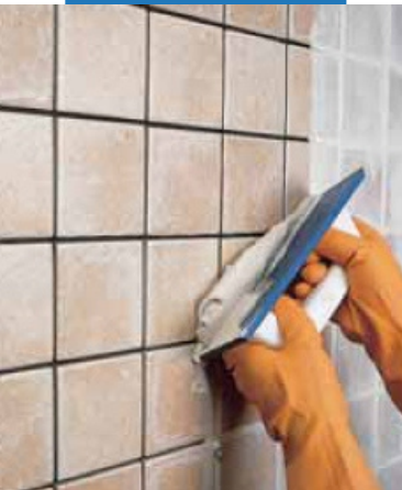
Заполнение швов плитки одинарного обжига на стене резиновым шпателем
