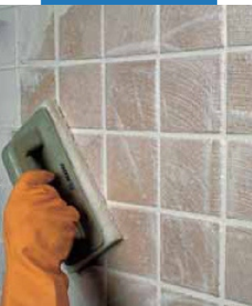
Очистка плитки одинарного обжига абразивным падом
