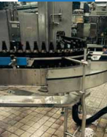
Пример заполнения швов в напольном плиточном покрытии на пивном заводе
