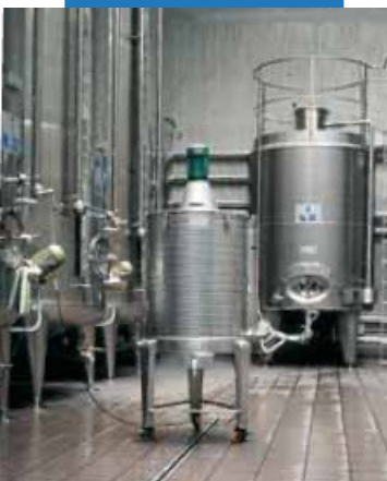
Пример заполнения швов напольном плиточном покрытии на винном производстве
