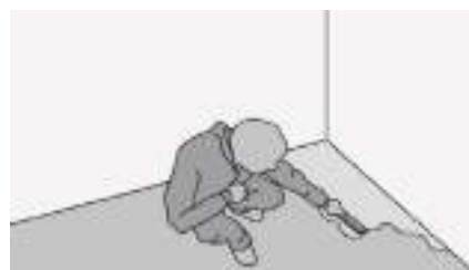
Рис. 21. Выравнивание оснований
