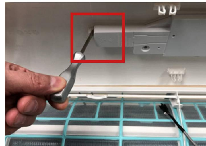
3. Отверткой с плоским жалом подденьте язычок корпуса дисплея, сдвиньте отвертку влево и выведите язычок из зацепления.
