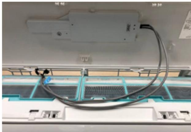
8. Застегните модуль дисплея на верхней панели, закрепите его винтом.
