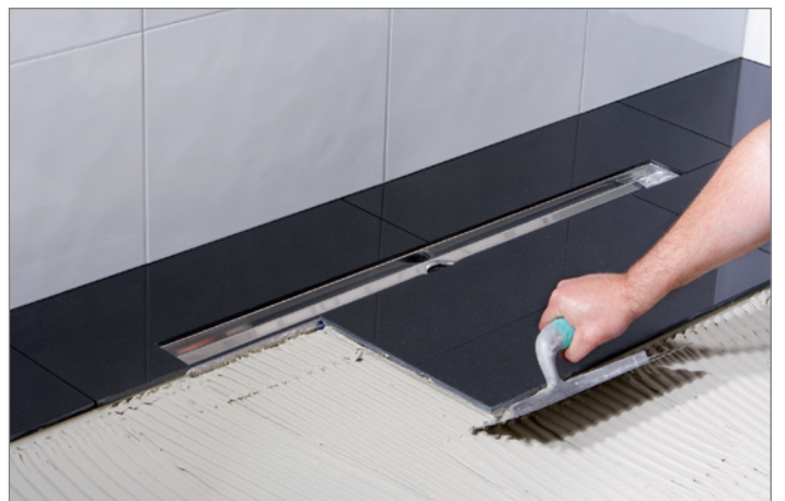
16. Kleber auftragen und Bodenplatten verlegen Apply glue and floor plates
