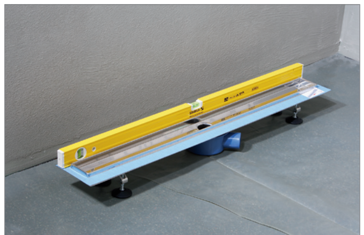
4. Montagefüße (optional) anschrauben, Duschrinne aufstellen und ausrichten Install mounting feet (optinal), set up and align drainline channel
