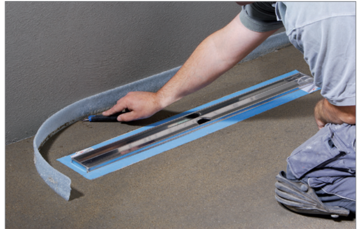
8. Überstehenden Randdämmstreifen abschneiden Cut off remaining edge-noise-strip
