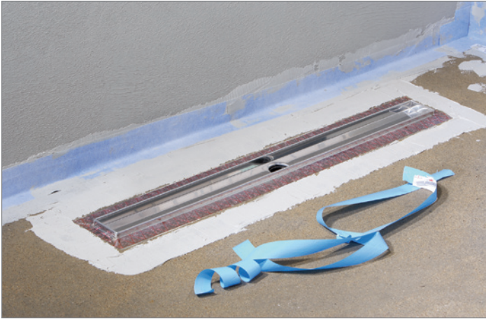
11. Ersten Dichtanstrich um Klebeflansch auftragen und Schutzfolie abziehen Apply seal painting around glue flange and remove protection foil
