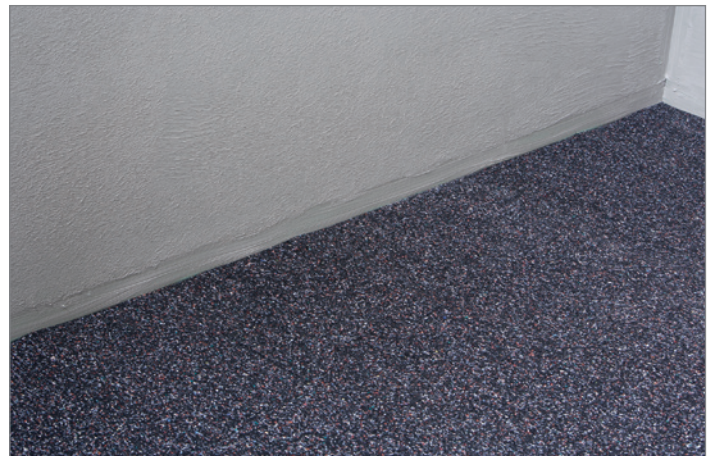
2. Drainbase-Schallschutzmatte auf Rohfußboden legen Cover concrete floor with Drainbase sound insulation mat
