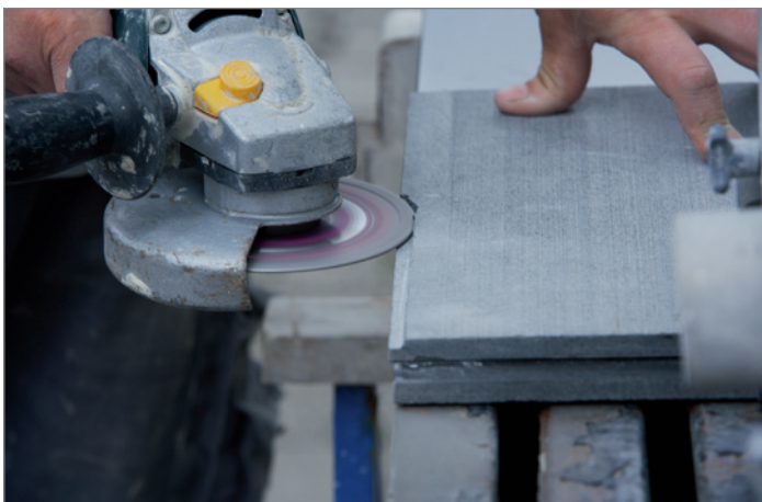
15. Einfassung mit geeigneten Werkzeug (z. B. Steinfräse, Winkelschleifer) herstellen Moulding with suitable tools (e.g. stone milling cutter, angle grinder)
