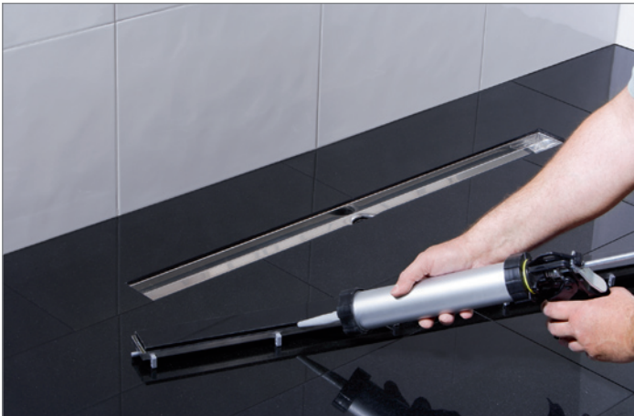
19. Ausgeschnittene Platten in Fliesenmulde einlegen, Fugen mit geeigneter elastischer Fugenmasse (z. B. Silikon) ausspritzen Insert cut out plates in hollow tile, grout with suitable elasticated material (e.g. silicon)
