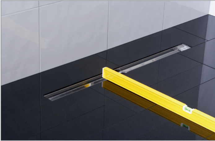
17. Gefälle vor Trocknung kontrollieren Check slope and drying
