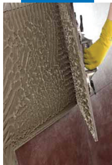
Необходимо смачивать 100% обратной стороны плитки при укладке крупноформатного гранита
