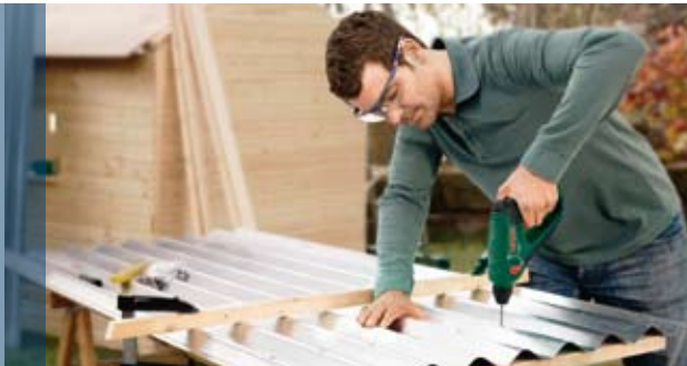
При постройке навеса приходится много сверлить и заворачивать. С помощью Uneo все будет просто.
