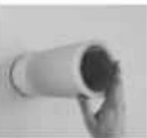
3. Сдвинуть фильтр в сторону помещения максимально близко к люкнуству, но так, чтобы он не мешал установке аномостата в трубе.
