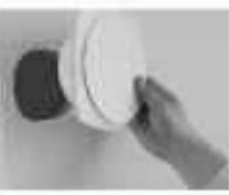
4. Закрепить аномостат или торцевую пластиду на стене при помощи четырех дюбелей и саморезов.
