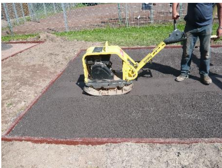
Финишная трамбовка выровненного основания
