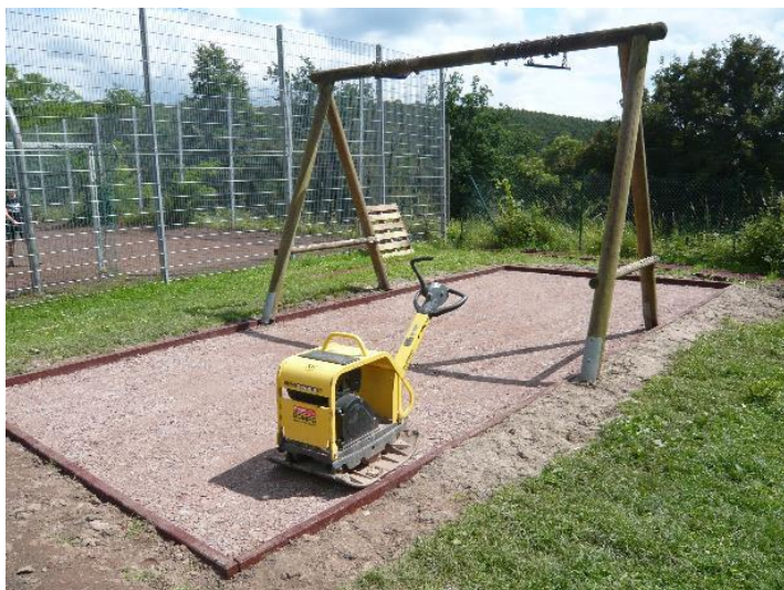
Вибротрамбовка основания из щебня
