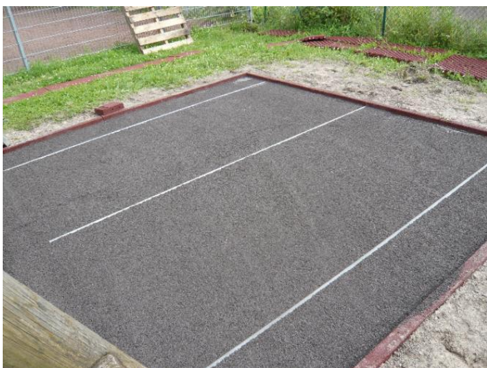
Выравнивание основания при помощи маяков
