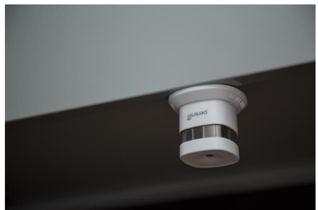
Рисунок 4 – Варианты установки датчика дыма
