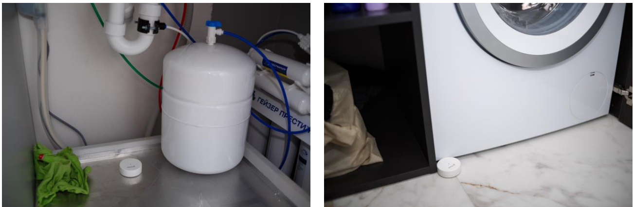
Рисунок 4 – Варианты установки датчика протечки
