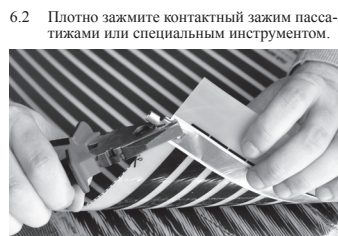
Рис. 4. Крепление контактного зажима к термопленке
