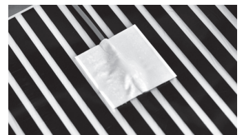
Рис. 11. Установленный и приклеенный датчик температуры пола. Вид снизу термопленки
