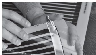
Рис. 3. Установленный на термопленку контактный зажим
