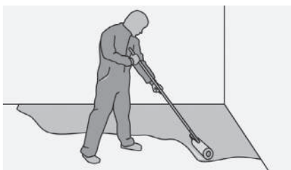
Рис. 20. Грунтование стяжки
