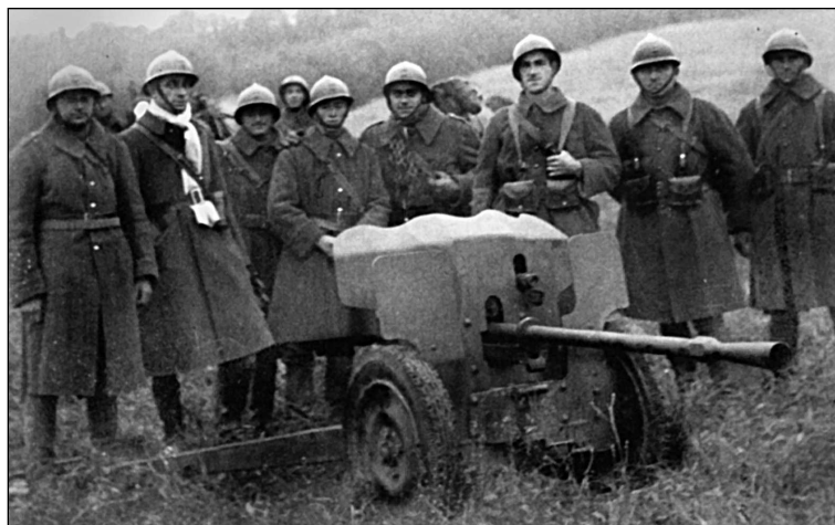
Французская 25-мм противотанковая пушка SA Mle 1934 из состава кавалерийской части в ходе учений в районе Арденн, 1934 г.
