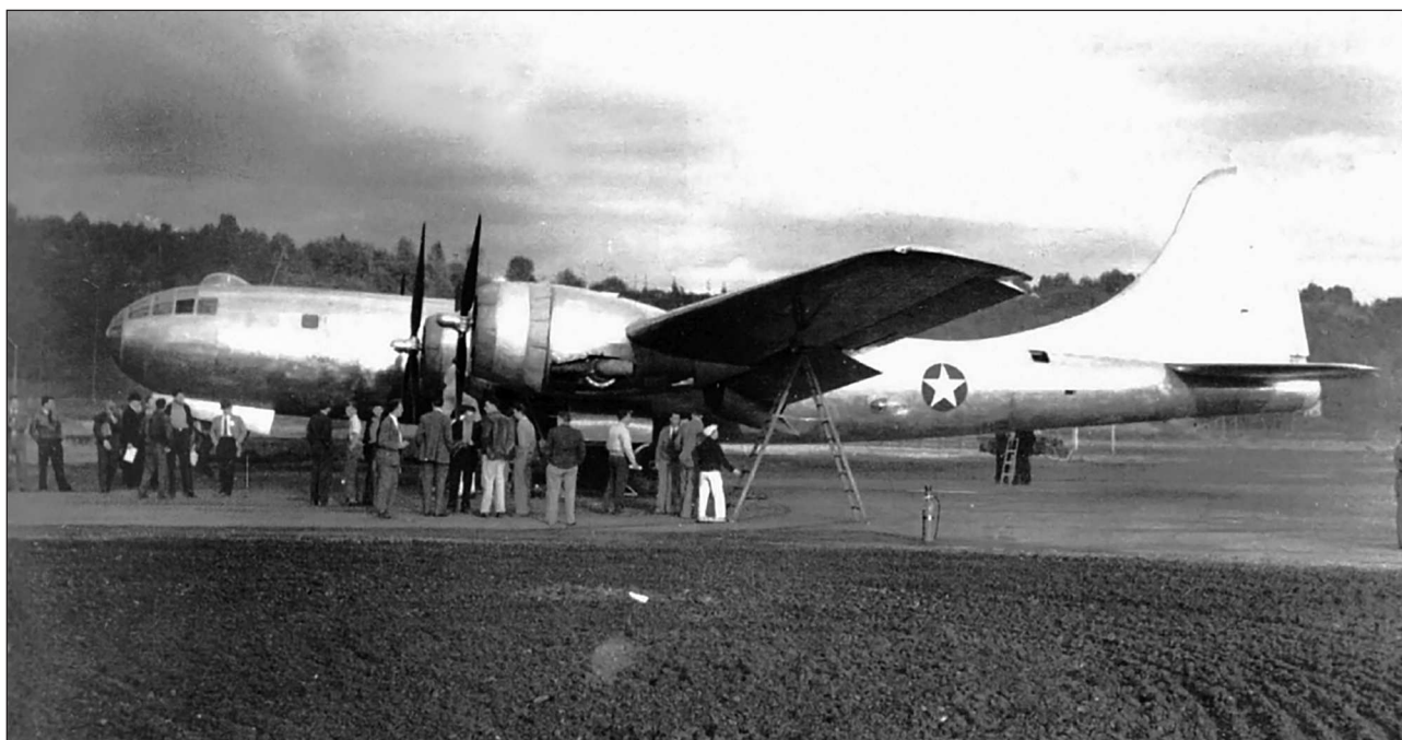
Второй прототип ХВ-29 (41-0031) не имел окраски. Обратите внимание на надстройку над кабиной пилотов. В этом обтекателе размещалась антенна радиопеленгатора. В дальнейшем антенну уменьшили, и на серийных машинах этой надстройки не было. Самолёт был потерян 18 февраля 1943 г.
