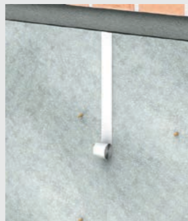
2. Для формирования нахлеста смежных полотен отделите геотекстиль на требуемую ширину (минимум 10 см). Нанесите двухстороннюю ленту PLANTERBAND DUO шириной 75 мм на место отделенного геотекстиля. Затем установите следующее полотно мембраны и соедините полотна «шип в паз».
