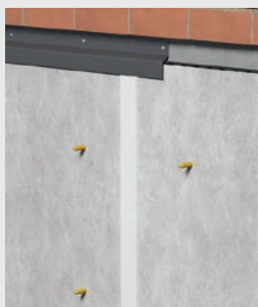
3. Выполните крепление отделенного геотекстиля на поверхности вновь установленного полотна двусторонним скотчем, строительным феном или с помощью клея.
