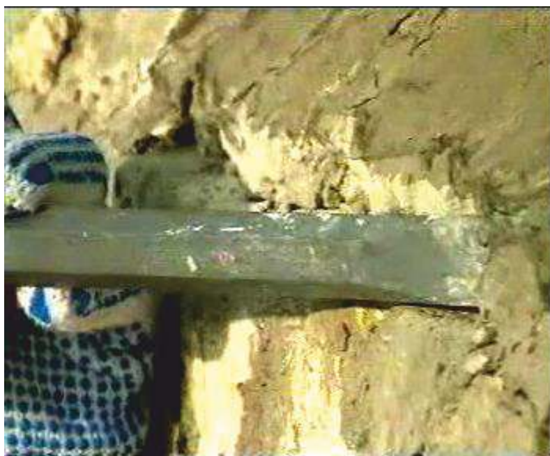
Рисунок 4 – Удаление штукатурного слоя зубилом
