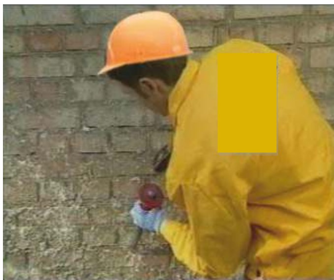
Рисунок 2 – Очистка поверхности зубилом и молотком
