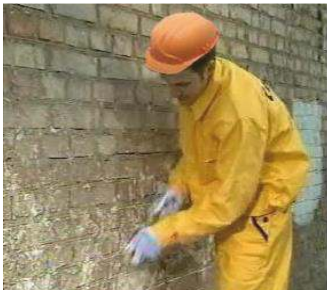
Рисунок 3 – Удаление отделочного слоя щеткой
