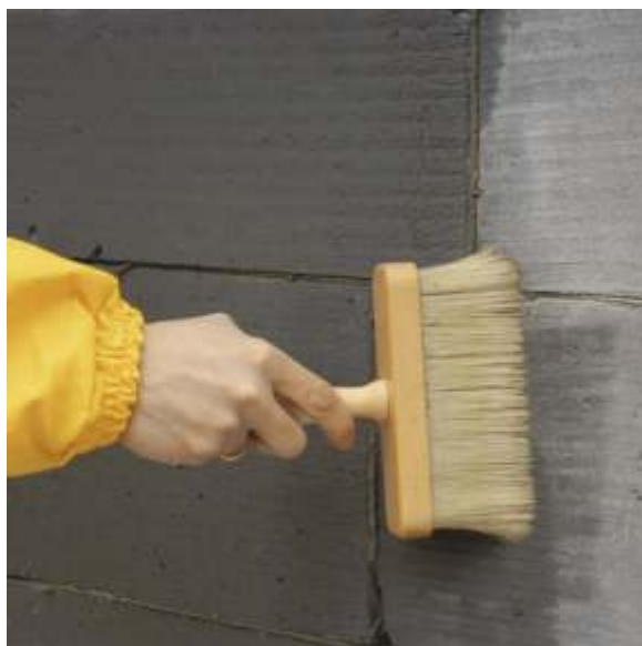
Рисунок 8 – Грунтование поверхности основания кистью
