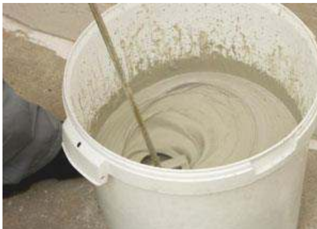
Рисунок 7 – Приготовление состава из сухой смеси и воды
