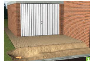
1) Выкопайте траншею и подведите трубу DN 100 для соединения лотков с ливневой канализацией шириной равной ширине лотка + 100мм с каждой стороны.
