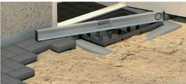
4. В случае установки поддона с использованием канализации - подключить снизу трубу диаметром 110 мм и установить поддон на бетонное основание.
