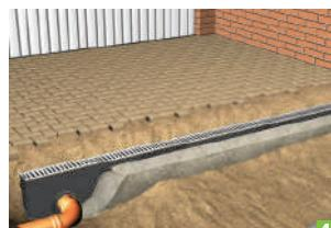
4) При установке в местах проезда автомобиля первые ряды брускатки должны быть уложены на то же бетонное основание, что и сам лоток.
