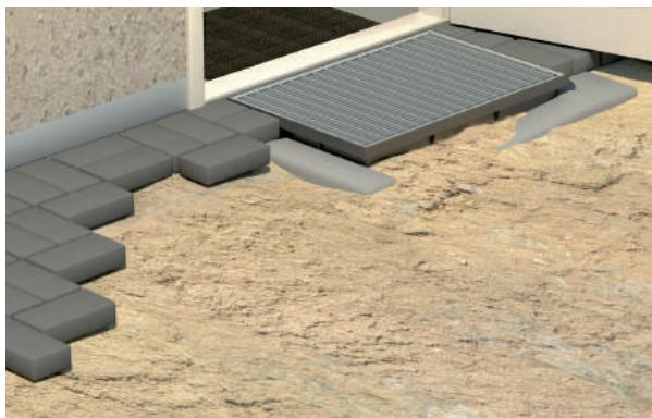
3. Проверить горизонтальность установки. При необходимости - скорректировать. Вокруг установленного поддона уложить плитку.
