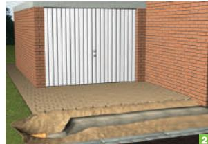
2) Для укладки лотков следует подготовить основание из бетона класса В15 высотой 10 см и шириной 35 см на гранитном щебне фракции 5-20 мм.
