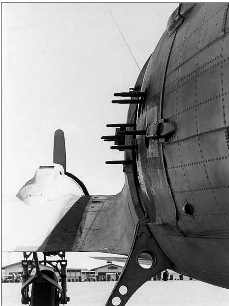
АС-47 с промежуточным вооружением из одноствольных пулеметов калибра 7,62 мм. На фото видны стволы восьми, вместо десяти штатных, пулеметов
