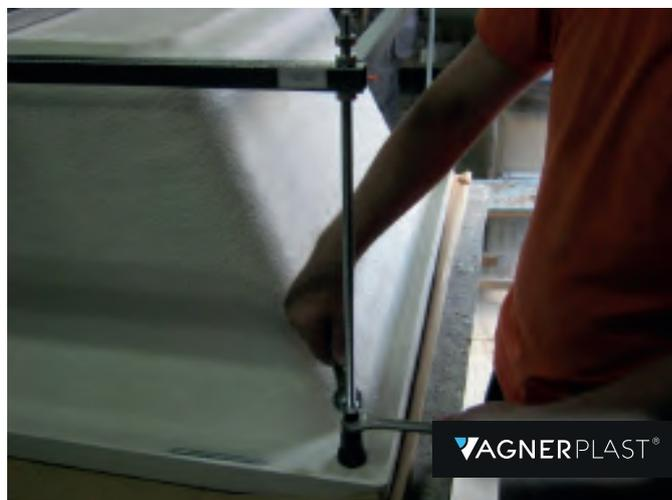
⑨ На шпильки накручиваются ножки
