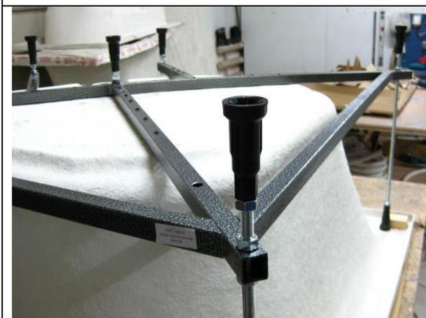
Каркас следует выровнять по ванне таким образом, чтобы пластиковые насадки в верхней части высоких резьбовых шпилек (при рабочем положении ванны) располагались на горизонтальной плоскости между внешним загибом бортика и стенкой ванны.
