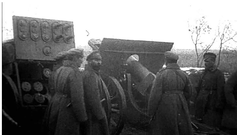
6-дм полевая гаубица системы Шнейдера обр. 1910 г. Русской Императорской армии ведет огонь, Первая мировая война. Обратите внимание на ход зарядного ящика слева от орудия и на большой откат ствольной группы гаубицы при выстреле. Стоп-кадры из кинохроники того времени, ЦГАКФД
