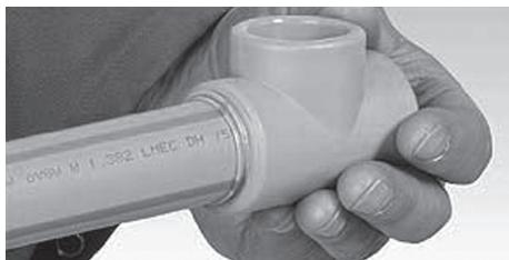
Далее следует подержать соединенные элементы некоторое время, после чего произойдет сопряжение и естественное охлаждение сваренных деталей.
