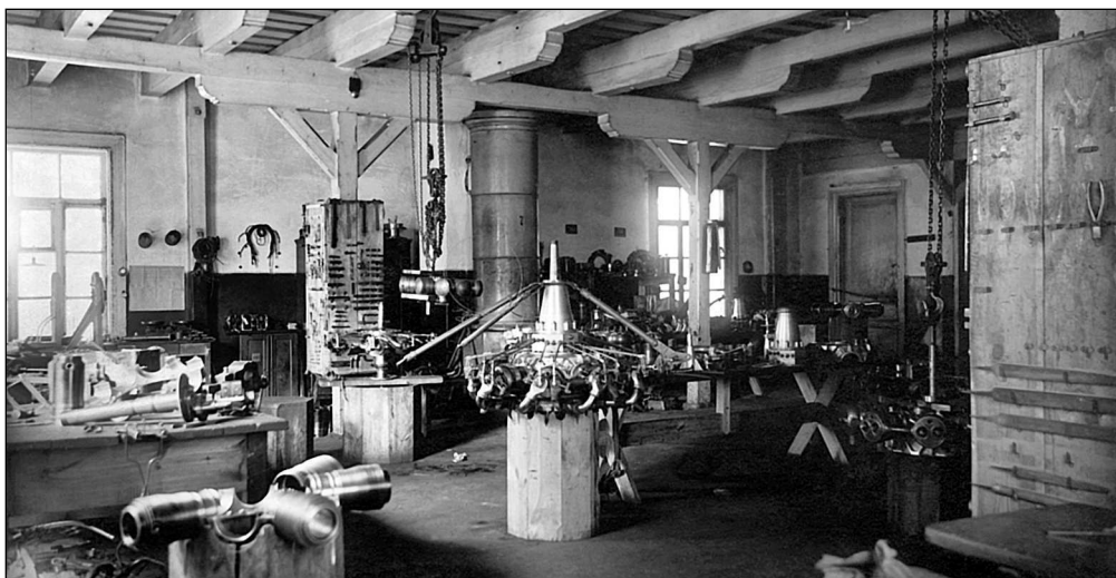
Ремонт авиадвигателей в мастерских 6-го авиапарка. В центре помещения в стадии сборки находится звездообразный «Сальмсон», устанавливаемый на самолетах «Ана-саль», «Лебедь-XII» и летающей лодке М-9
