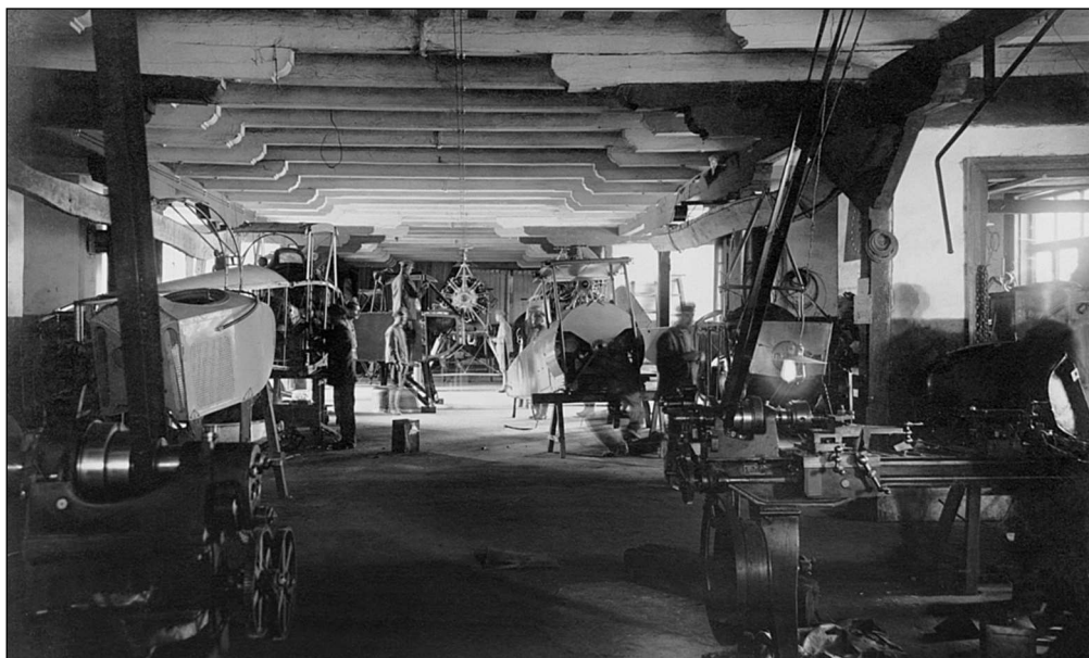
Сборка и ремонт военных самолетов в период Первой мировой войны велись в специализированных авиапарках (полевых ремонтных авиазаводах), которые комплектовались необходимым техническим персоналом и оборудованием. На снимке представлена сборочная мастерская 6-го авиапарка, размещенного в городе Львов в 1916 г. Устанавливается самолет «Спад» SA-2 с отстыкованной передней кабиной воздушного стрелка и фюзеляж полутораяплана «Ньюпор-Х»
