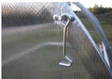
Рисунок 2.2 - Вид крепления петель, заверток, крючка и задвижки.
