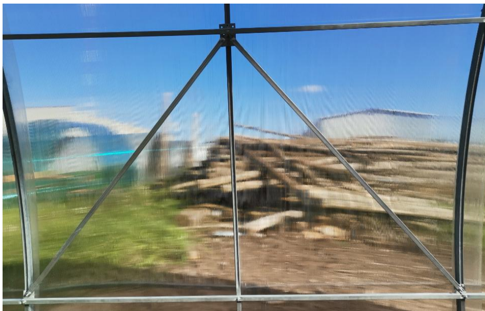
Рисунок 3.3 – Установка диагоналей.
