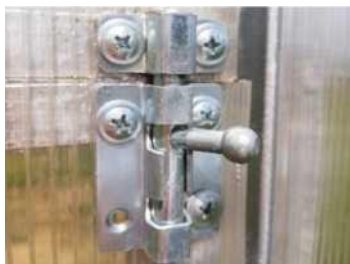
Рисунок 2.2 - Вид крепления петель, заверток, крючка и задвижки.
