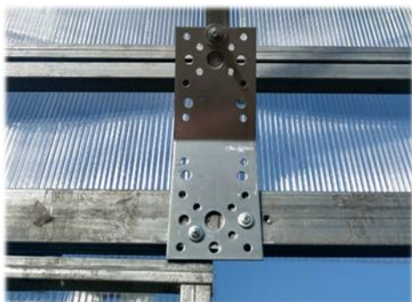
Рисунок 3.4 – Крепление верхних диагоналей.
