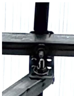
Рисунок 3.4 – Крепление верхних диагоналей.
