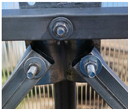
Рисунок 3.2 –Крепление боковых диагоналей
