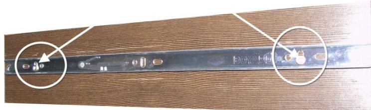
3) Оставшуюся часть направляющей крепим с помощью саморезов 3,5x16 (К стойке кровати).
