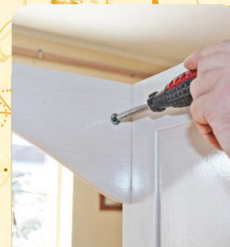
12. Зафиксировать верхнюю царгу эксцентриками
