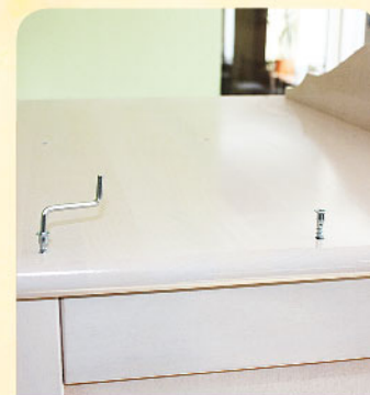
14. Зафиксировать комфирматом верхний горизонт к большому бокам
