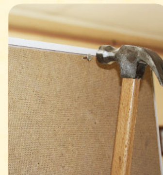
15. Зафиксировать гвоздями ДВП задней стенки
