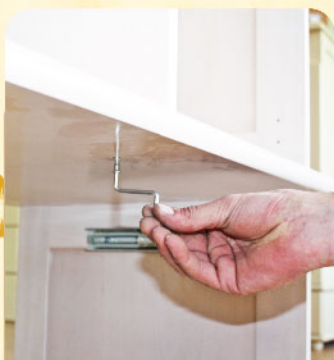
8. Соединить комфирматом разделительный бок с средним горизонтом
