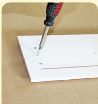
22. Установить винт эксцентрика в фасад ящика
