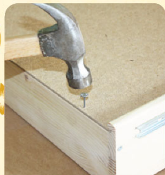
26. Зафиксировать ДВП гвоздями к задней стенке ящика
