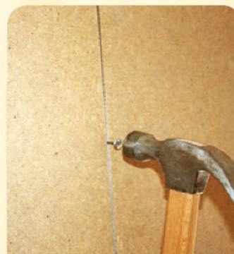
16. Соединить два ДВП между собой по разделительному боку гвоздями
