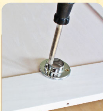
5. Зафиксировать штагодержатель на правом и разделительном боках самарезом 4x16
