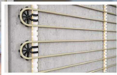
Стеновое отопление - мокрый метод
