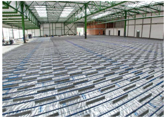
Система KAN-therm – панельное отопление (1500 м 2 ) в перевалочном цехе рассады салата - Польша, Косув (Kosów).
