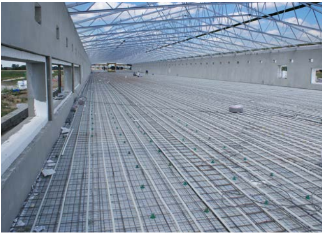
Система KAN-therm – отопление птичника (2500 м 2 ) в условиях содержания птицы на подстилке – Польша, Брожово Велке (Brzozowo Wielkie).
