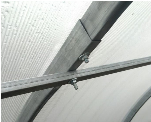
Рисунок 6 – Вид взаиморасположения дуг и поперечин при их соединении
