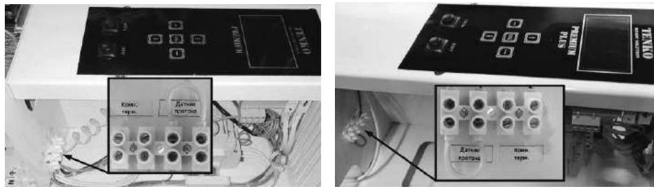
Рисунок 14.2 – Расположение клеммы подключения внешнего (комнатного) термостата: *a* – в котлах «Премиум»; *b* – в котлах «Премиум Плюс»
