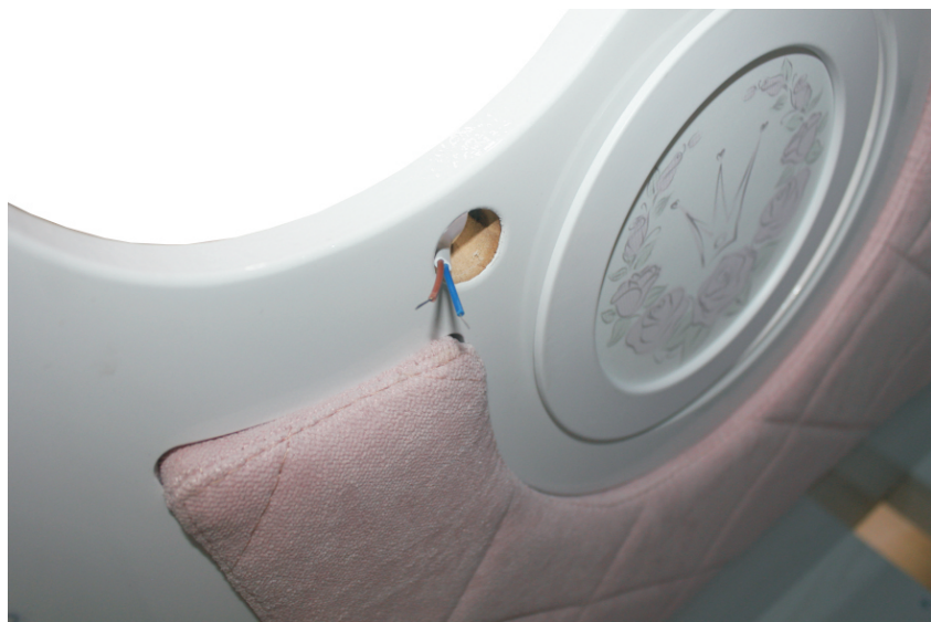
Шаг 2. Вытянуть провод светильника в отверстие под выключатель, при необходимости повернув светильник.
