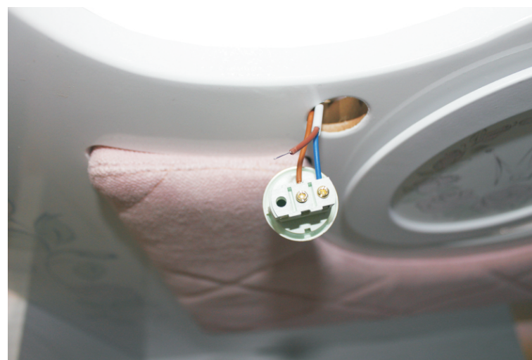
Шаг 4. Подключить один провод светильника к свободной клемме выключателя.
