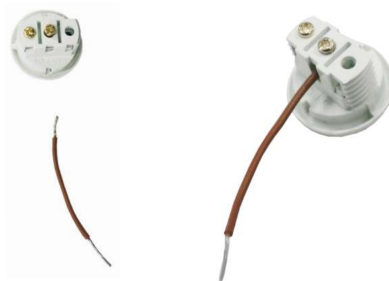
Шаг 3. Подключить короткий провод к клемме выключателя.
