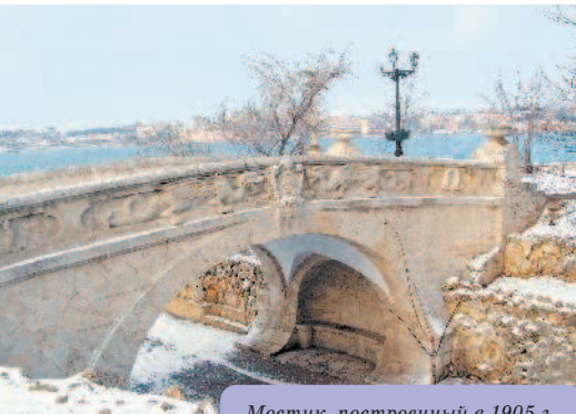
Мостик, построенный в 1905 г.
