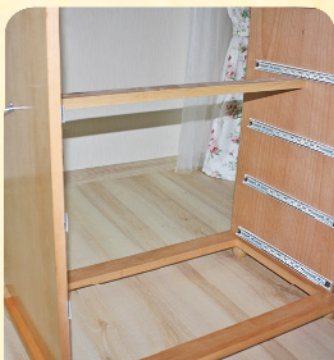
6. Установить царгу между боками, зафиксировать конфирматом
