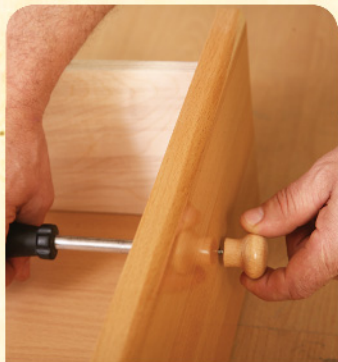
20. Зафиксировать ручки на фасадах саморезом 4x40
