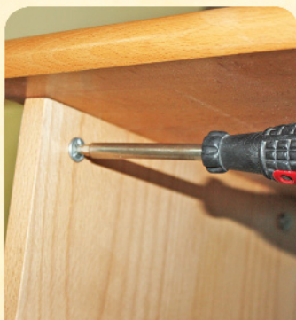
10. Зафиксировать эксцентриком
