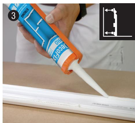
**Apply adhesive over the entire glue surface** | Breng lijm aan over het volledig lijmpervlak | Appliquez la colle sur toute la surface dédiée | Bringten Sie Kleber an auf der gesamten Klebefläch | Aplicar adhesivo sobre toda la superficie de adhesión. | Нанесите клей на всю поверхность профиля
