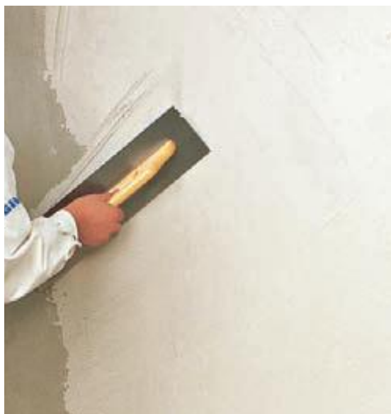
Рисунок 4 - Нанесение на стену
