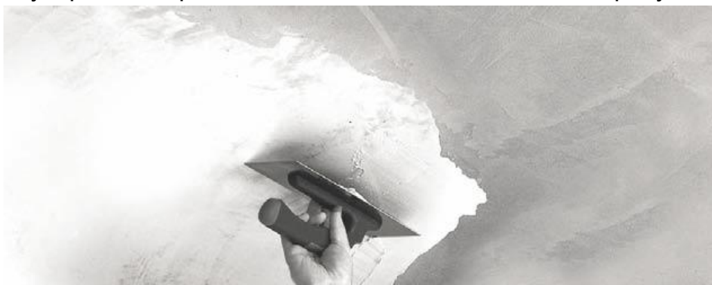
Рисунок 3 - Нанесение на потолок.
