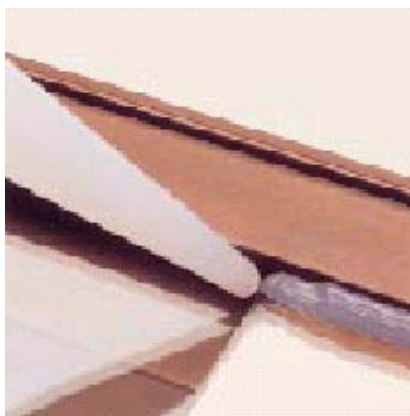
Уплотнение алюминиевой оконной рамы
