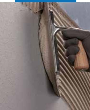
Укладка напольных покрытий, используя Ultramastic III
