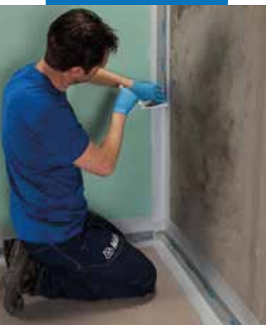
Нанесение Mareband PE 120 используя Maregum WPS
