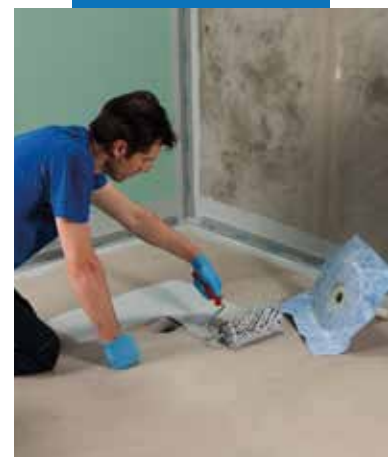
Установка Drain Vertical , используя Mapegum WPS
