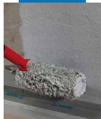
Нанесение Mapegum WPS с помощью валика
