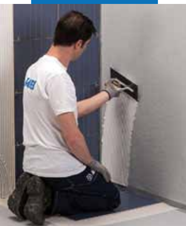
Укладка напольных покрытий, используя Keraflex Maxi S1
