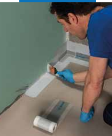
Нанесение Mareband PE 120, используя Maregum WPS
