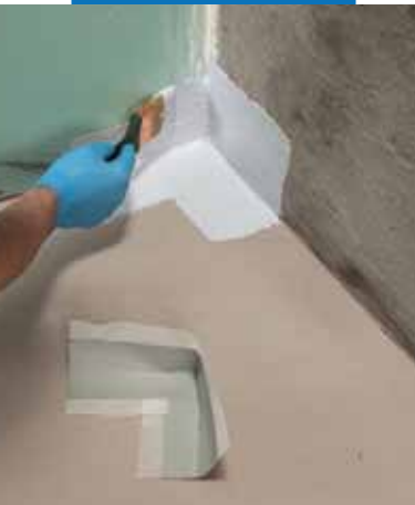
Нанесение на угол 90° углового Mareband PE 120, используя Maregum WPS
