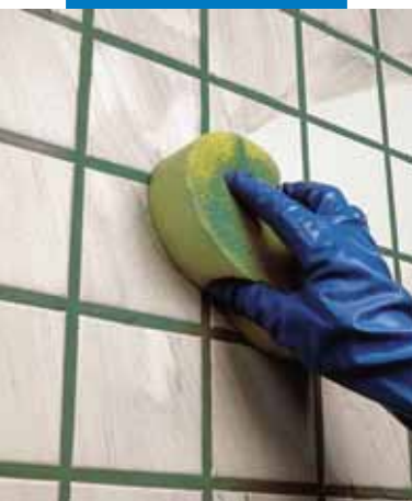
Окончательная очистка плитки с помощью губки
