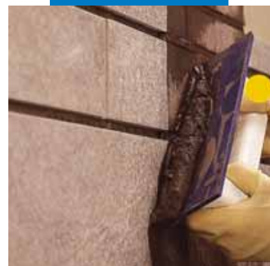
Заполнение швов на стене составом Ultracolor Plus с помощью резинового шпателя
