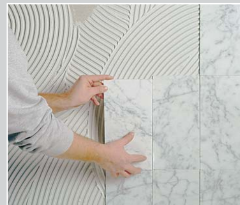
Укладка светлого мрамора на клей LITOSTONE K99
