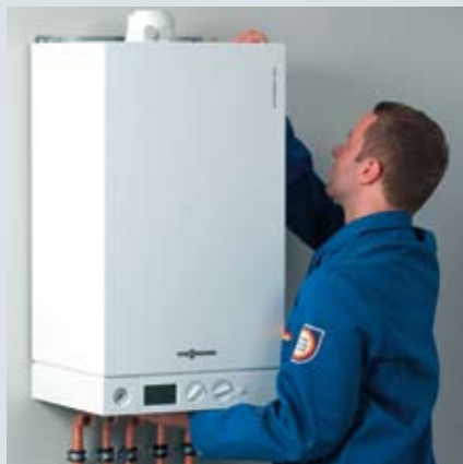
2. Закрепите котел на стене
