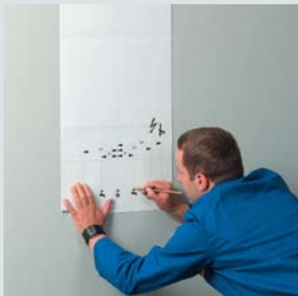
1. Используйте специальный шаблон для монтажа
