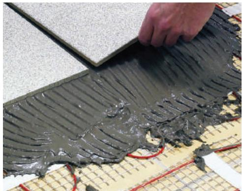
Работы, связанные с нанесением плиточного клея, требуют соблюдения определенного температурного режима (от +5 °C до +25 °C). Это требование относится как к температуре основания, так и к воздушной среде. Аналогичный температурный режим должен сохраняться и на протяжении времени, необходимого для отвердения плиточного клея. Проследите за тем, чтобы во время проведения указанных работ в помещении не было сквозняков.
