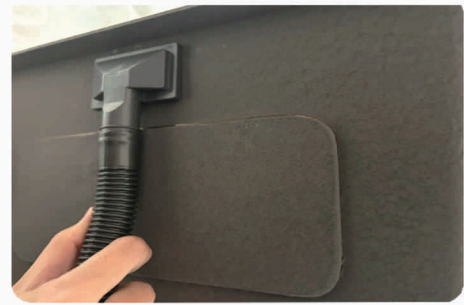
11. Совместите переливное устройство с переливным отверстием в раковине, обращая внимание на расположение отверстий для винтов в переливном устройстве.
