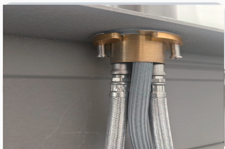
3. Вставьте смеситель в круглое отверстие раковины, подключите холодный и горячий водопровод, а также трубу для утяжеления и зафиксируйте смеситель.
