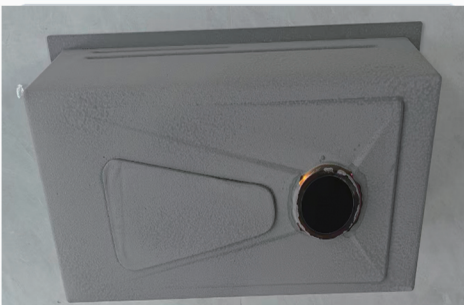
2. Переверните раковину и установите её на место установки. Обведите контур по краю, затем уберите раковину и нарисуйте линии резки внутри контура.
