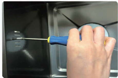
12. Используя крестовую отвертку, закрутите винты в области переливного отверстия, чтобы надёжно закрепить переливное устройство.
